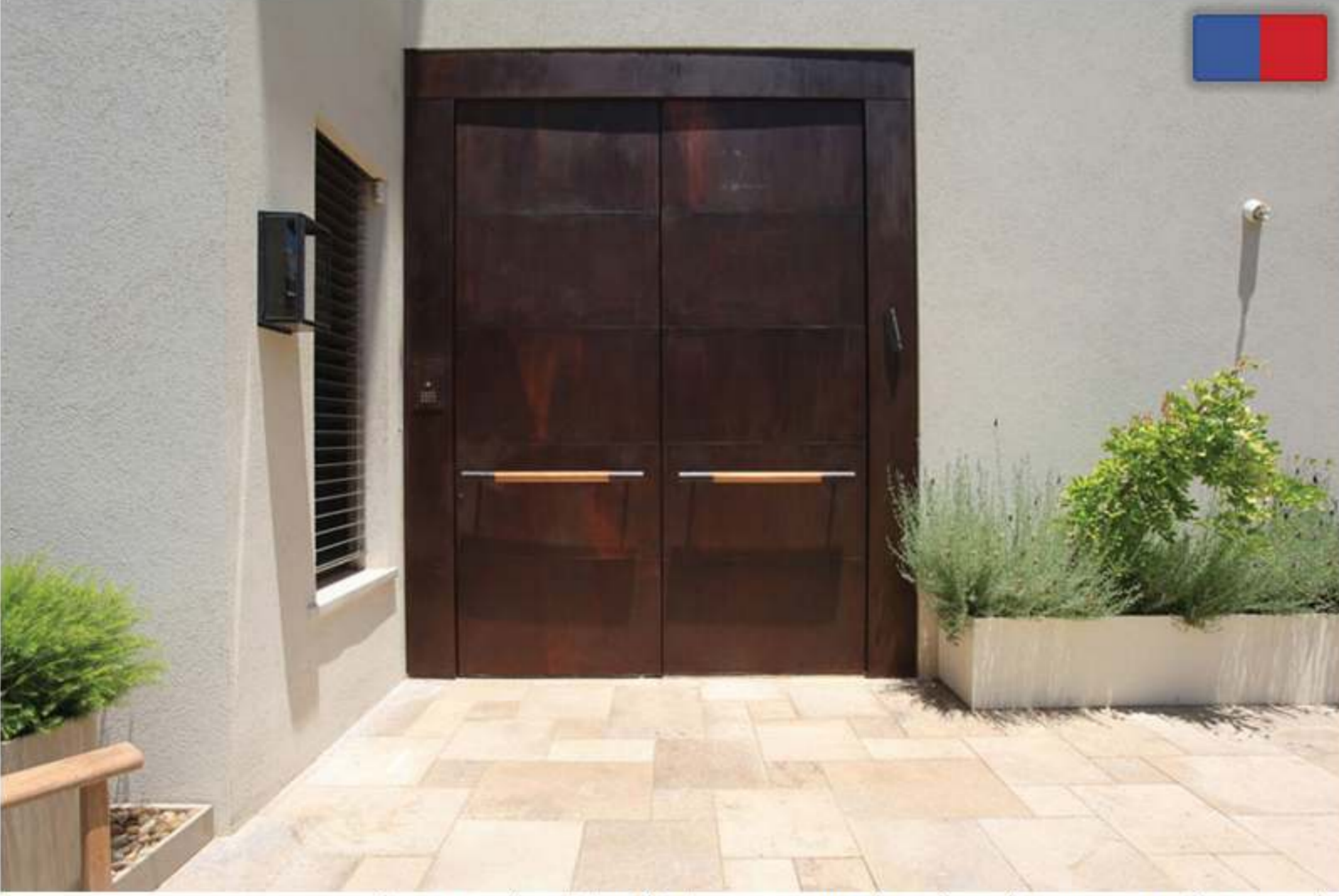
דלת כניסה מפלדת קורטן. אדריכל: קימל אשכולות. תכנון וביצוע: Adam Steel. צילום: דודו אזולאי
